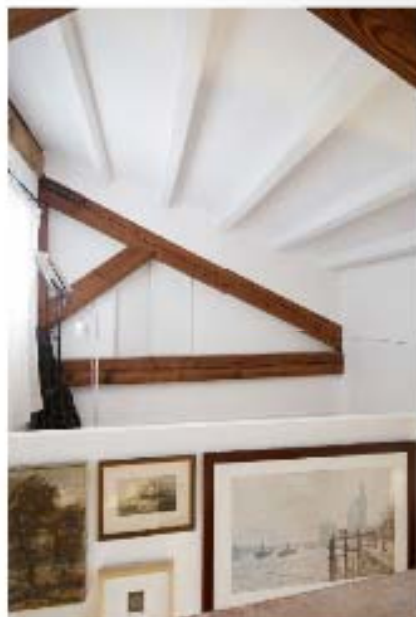
Un pequeño espacio con el que no contaban, y al que se accede a través de una escalera de mano.
